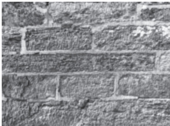
Fig. 7. — À l'ouest de la porte de la nef, moellons schisteux avec d'innombrables traces d'outil pour l'équarrissage.
