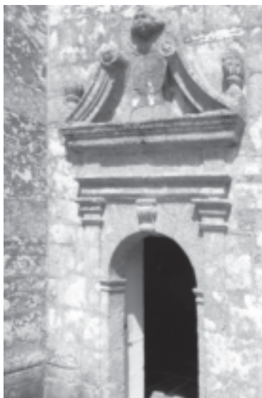
Fig. 5. — Porte d'entrée dans le transept sud. Cliché L. Chauris (4 août 2014).
