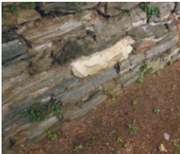
Fig. 26. – En bordure du chemin naguère emprunté par la voie Decauville descendant de la carrière vers l'estran. Dans le muret, moellons de schistes bleutés associés à un microgranite blanchâtre. Cliché L. Chauris.
