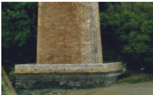
Fig. 15. – Protection basale de la pile orientale. Cliché L. Chauris.
