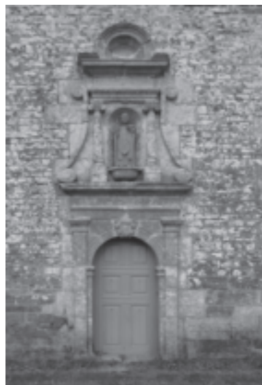
Fig. 6. — Porte d'accès dans la nef. Cliché L. Chauris (19 août 2016).
