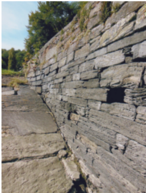
Fig. 29. — Au droit de Toul-Mahot, mur de soutènement de la route de corniche et cale d'accès à la rivière. Cliché L. Chauris.
