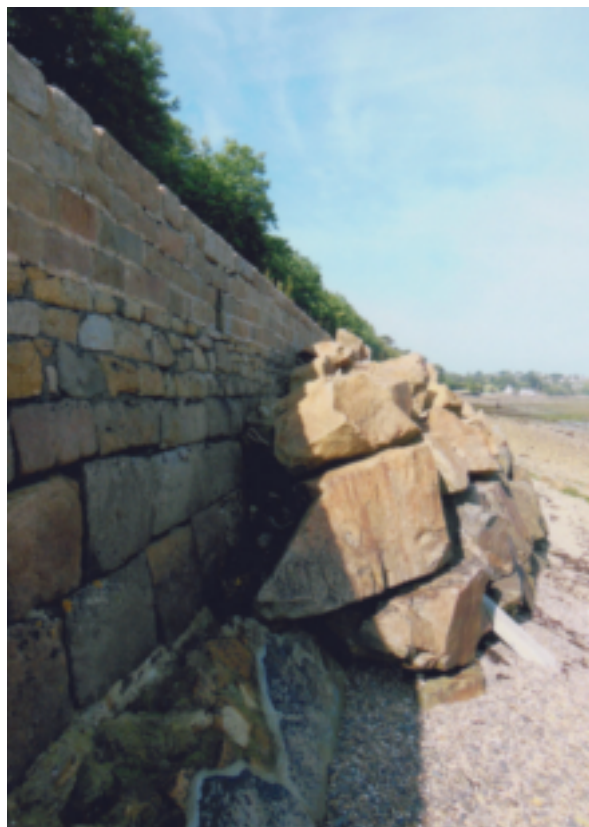
Fig. 28. – Déversement récent du gabbro et du granite de la carrière de Dividou en Garlan au pied du mur de soutènement, en granites du district de l'Île Grande, remontant à la Grande Guerre.
