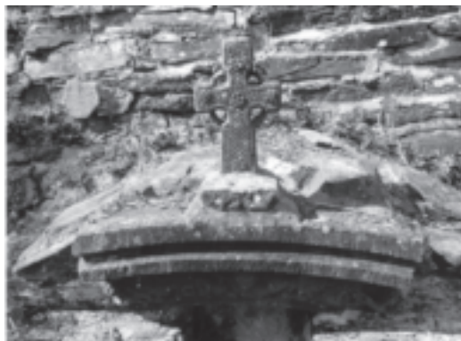
Fig. 15. – Partie sommitale de la fontaine. Moellons schisteux. Pierre de taille incurvée et croix en kersanton. Cliché L. Chauris (4 août 2014).
