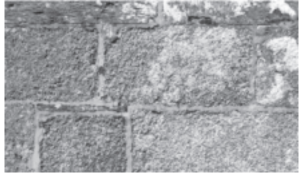
Fig. 9. – Granite sain, blanc-gris, à droite ; altéré, beige-brunâtre, à gauche. Cliché L. Chauris (4 août 2014).
