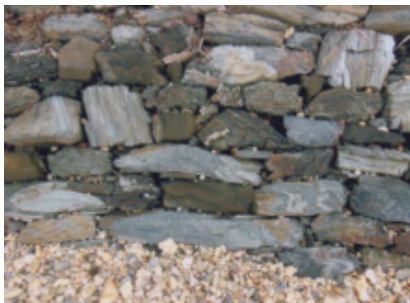
Fig. 27. – Sur l'estran, juste au nord de la lagune, aujourd'hui comblée, de Locquéholé, mur en pierres sèches formé d'éléments hétérométriques de schistes zébrés, édifié pendant la Grande Guerre.
