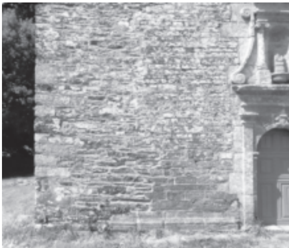
Fig. 3. – Élévation sud. À gauche de la porte, zone de contact avec la partie reconstruite. Cliché L. Chauris (4 août 2014).
