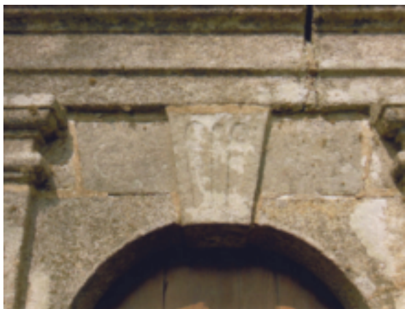
Fig. 22. – Clé de voûte en granite à grain fin, porte latérale sud de Saint-Sébastien.
