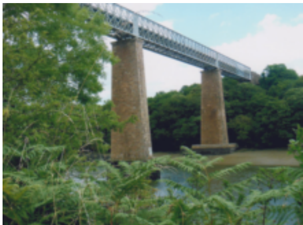
Fig. 14. – Piles centrale et orientale du viaduc. Cliché L. Chauris.
