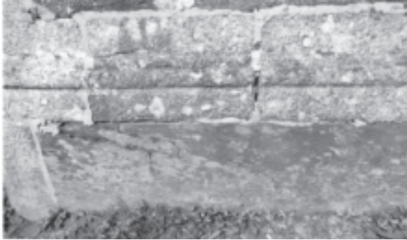
Fig. 8. – Grand moellon schisteux, placé verticalement, parallèlement à la schistosité. Cliché L. Chauris (4 août 2014).
