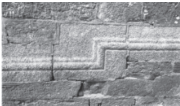
Fig. 10. – Élévation sud. Cordon basal, avec décrochement pour compenser la déclivité du sol. Cliché L. Chauris (4 août 2014).
