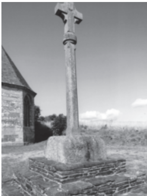
Fig. 16. – Le calvaire. Degrés en schiste. Socle du fût en granite de Plounéour-Menez. Fût et croix en granite de Brennilis. Cliché L. Chauris (4 août 2014).
