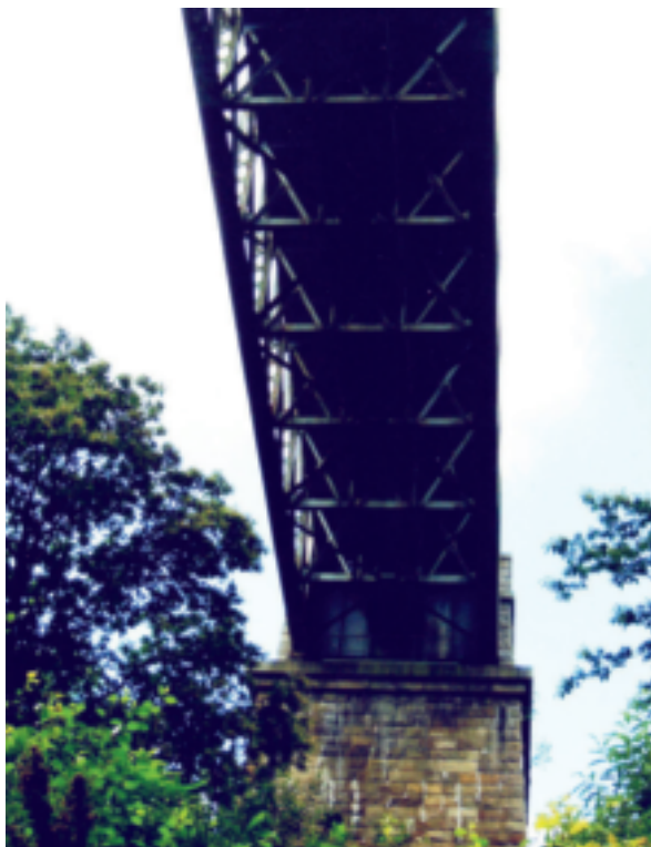
Fig. 17. – Sous le tablier métallique entre pile et culée occidentale. Cliché L. Chauris.
