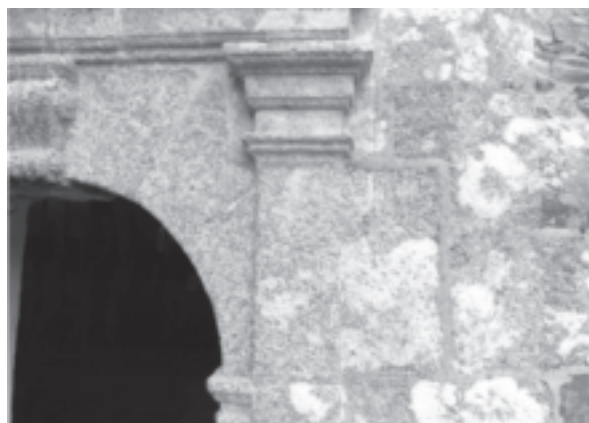
Fig. 11. – Porte du transept sud. Granite à gros grain du massif de Plounéour-Ménez. Seul le motif mouluré est en granite à grain fin. Cliché L. Chauris (4 août 2014).
