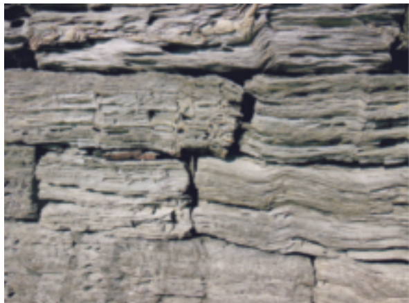
Fig. 30. – Schistes de provenance locale, profondément érodés selon la foliation, dans le mur de soutènement de la route de corniche près de Toul-Mahot.
