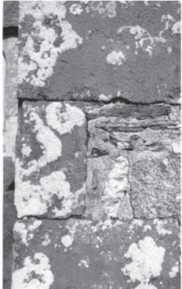
Fig. 13. – Chaînage d'angle ouest/nord de la nef, en kersanton.
