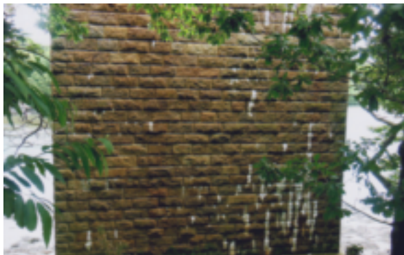
Fig. 16. – Parement vu en moellons assisés de la pile occidentale. Cliché L. Chauris.
