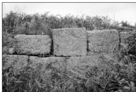
Fig. 6. – Carantec, vestiges de la batterie de l'île Callot. Cliché L. Chauris.
