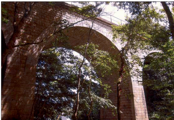
Fig. 21. – Morlaix, voie ferrée , pont II, élégance du viaduc à trois arches surgissant au milieu des arbres. Cliché L. Chauris.
