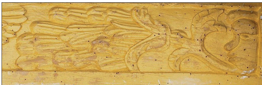
Fig. 3. – Détail de la sablière ouest. Cliché J. Lubin.
