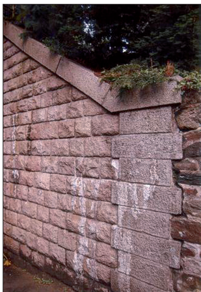
Fig. 20. – Morlaix, voie ferrée . Pont I sur la rue de La Villeneuve. Pierres de taille (chaîne harpée et rampant) en granite du Huelgoat. Cliché L. Chauris.
