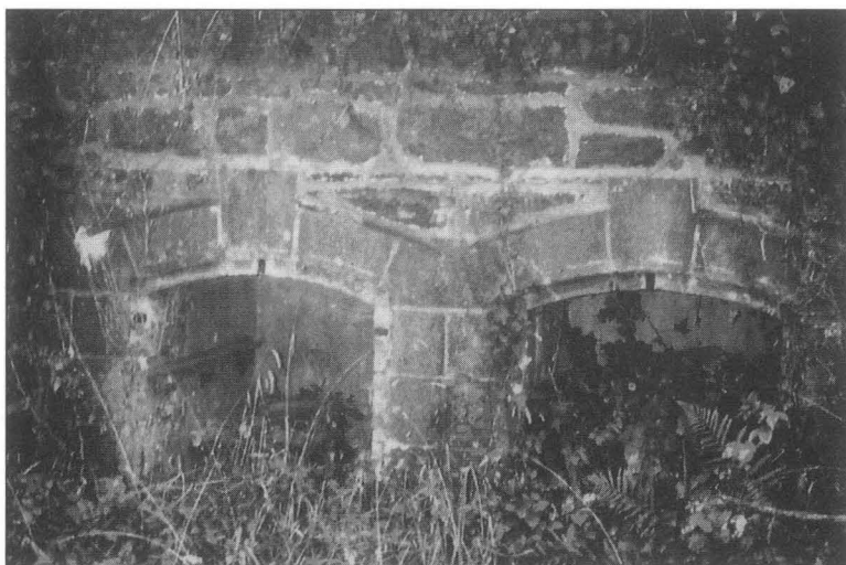
Fig. 33. – Batterie de Quillihouarn, niche double entre les traverses de la batterie, kersanton (encadrement) et gneiss (parements). Cliché L. Chauris.
