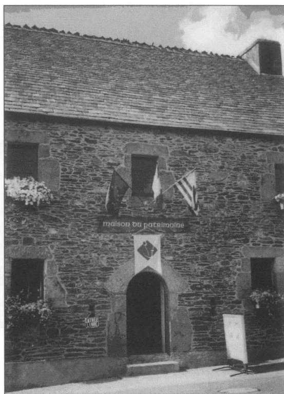
Fig. 24. – « Maison du Patrimoine », en face de l'église. Pierres de taille en granite de Plounéour-Ménez ; moellons schisteux, dominants, associés à quelques éléments quartzeux.
