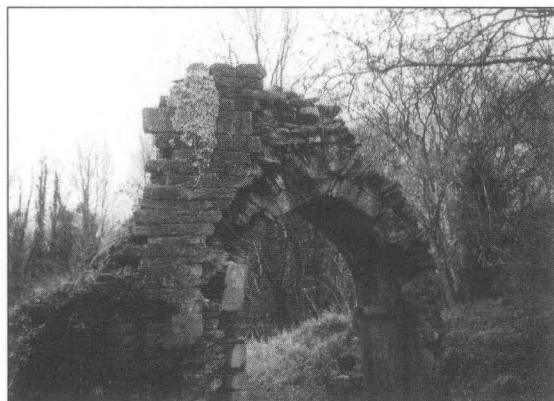
Fig. 19. – La Forest-Landerneau, château de Joyeuse-Garde , portail d'entrée ruiniforme. Cliché L. Chauris.
