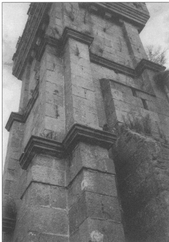
Fig. 5. – Contreforts de la tour en grands éléments façonnés dans le granite de Cléder. Cliché L. Chauris.
