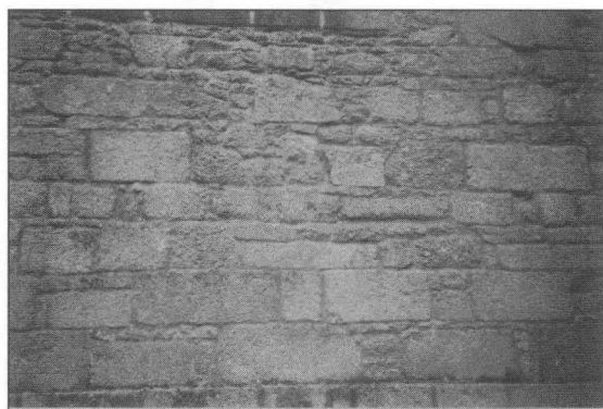
Fig. 8. – Partie inférieure de l'élévation méridionale.
