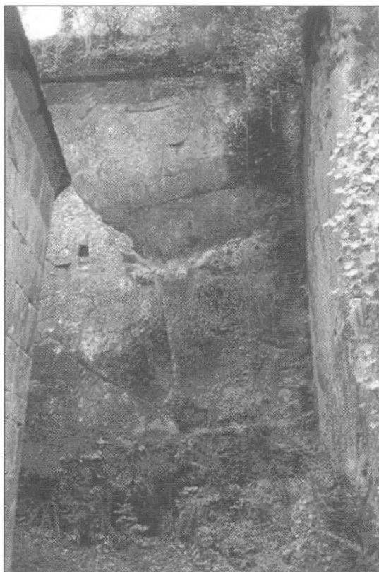
Fig. 3. – Ploërdut, Locuan , vue de la partie sud du front de taille faisant face au chevet de la chapelle, montrant les différents alignements d'entailles et de logements des fermes et des poutres de deux bâtiments successifs. Cliché J. Peuziat.
