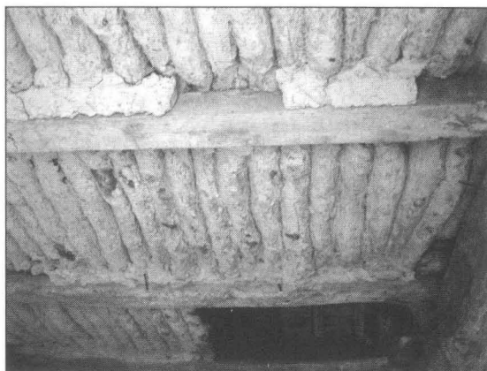
Fig. 9 et 10. – Deux procédés constructifs utilisés dans l'architecture rurale trégoroise : La pierre de Locquirec, pour certaines séparations, ici des stalles d'écurie, et les « quenouilles », pour les murs et les plafonds. Clichés J.-F. Joly.
