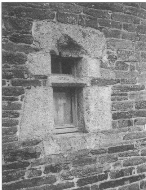
Fig. 26. – Petite fenêtre en granite de Plounéour-Ménez ; moellons schisteux régulièrement assisés. Cliché L. Chauris.
