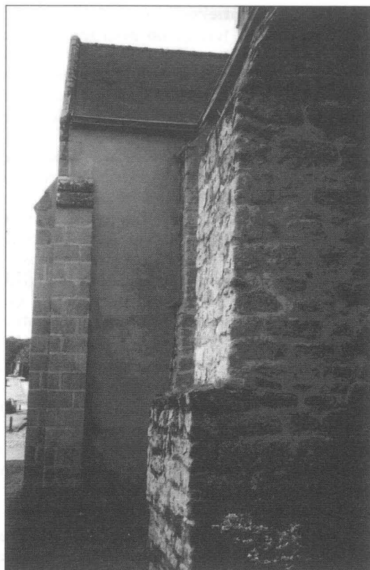
Fig. 6. – Contraste dans l'appareillage des contreforts du chœur (XIII e siècle) et de la nef (XIX e siècle). Cliché L. Chauris.
