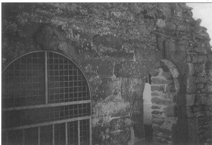
Fig. 27. – « Espace Anne-de-Bretagne », encadrement d'une porte (1673 ou 1675 ?) en schistes noirs métamorphisés en cornéennes compactes. Cliché L. Chauris.
