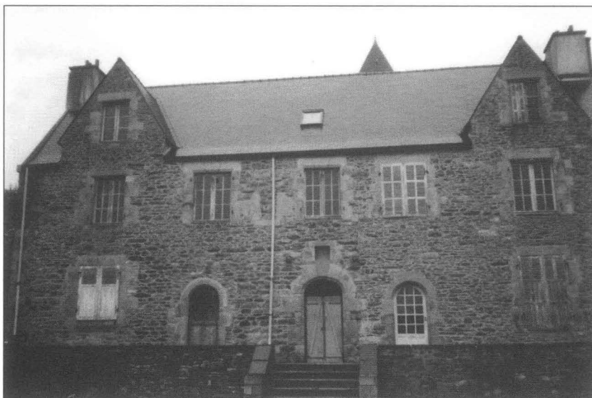
Fig. 1. – Brest, manoir de Kerisbian , façade principale, défigurée par l'ouverture de grandes baies et, semble-t-il, par l'ajout de deux ailes latérales.
