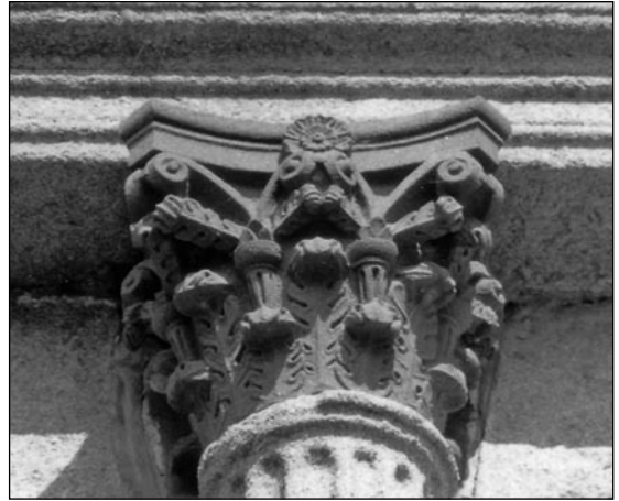
Fig. 12. – Porte monumentale. Chapiteau en kersanton noir à grain fin en couronnement de colonne.
