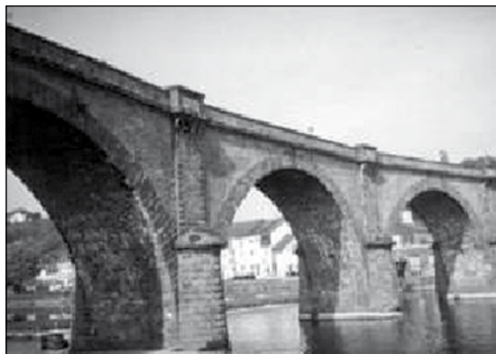
Fig. 1. – Vue partielle du viaduc curviligne de Châteaulin, sur l'Aulne (côté aval). Arches de 20,50 m d'ouverture. Cliché L. Chauris.
