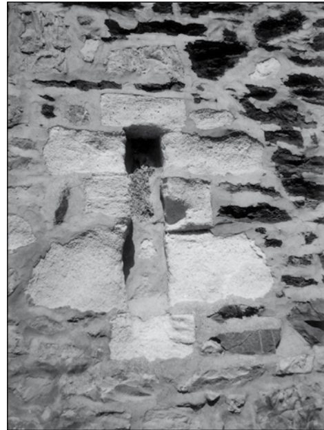
Fig. 9. – Réduit de Postolonnec (1860) en Crozon.
