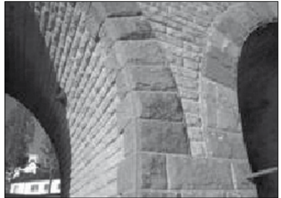
Fig. 4. – À la naissance des voûtes. Association du sombre kersanton de la rade de Brest au clair granite de Pontivy. Cliché L. Chauris.
