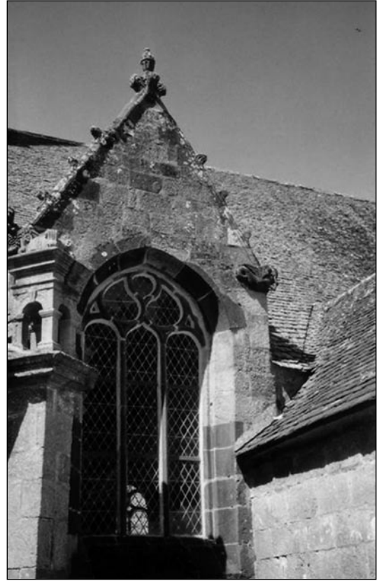
Fig. 6. – À l'ouest du porche méridional, baie surmontée d'un pignon. Association un peu aléatoire kersanton et granite.
