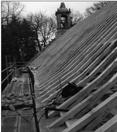
21. – Vue d'ensemble de la nouvelle charpente, avec les poinçons.
