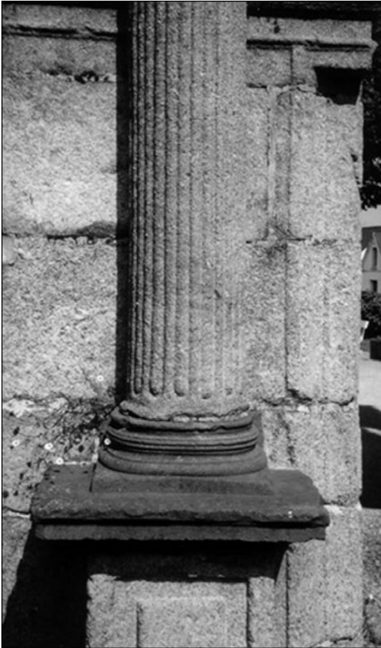
Fig. 11. – Porte monumentale. Soubassement, en kersanton noir à grain fin, de la colonne cannelée en granite de Brennilis.
