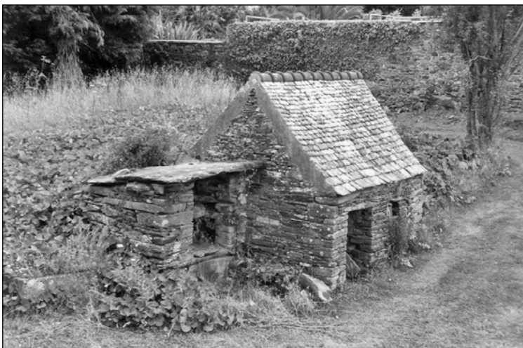
Fig. 22. – Petite construction à toiture en schiste de Locquirec disposé en pureaux décroissants. À gauche, puits avec énorme dalle schisteuse en couverture. Cliché M. Minor.
