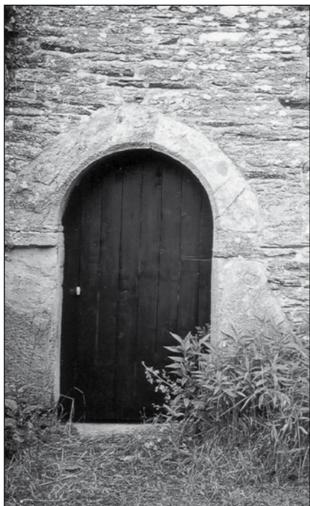
Fig. 23. – Porte cintrée en schiste de Locquirec, soigneusement façonné en grands éléments. Cliché L. Chauris.
