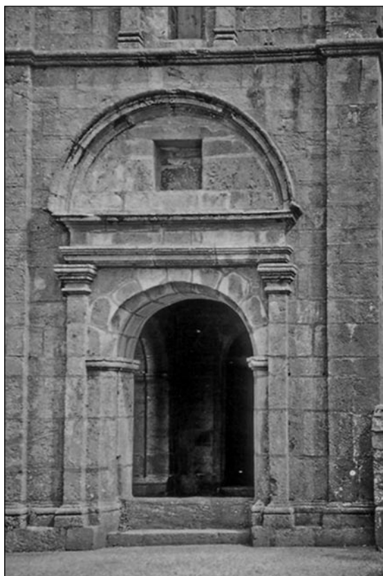
Fig. 9. – Partie inférieure du clocher-porche.
