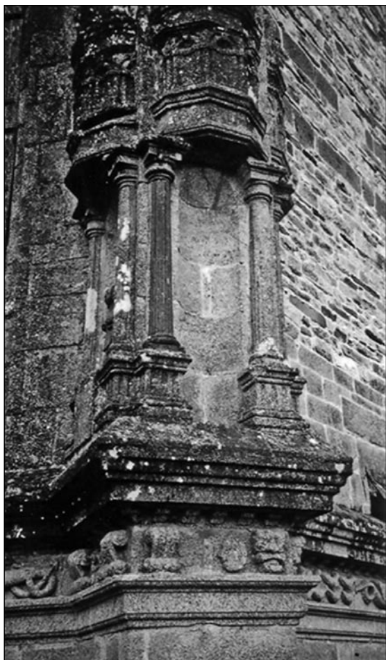
Fig. 15. – Sur un des contreforts du chevet, une seule colonnette est en kersanton noir, les autres sont en granite.
