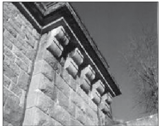
Fig. 5. – Couronnement d'un contrefort au sommet d'une pile. Cliché L. Chauris.
