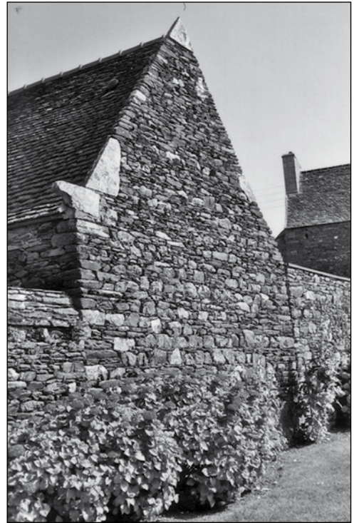
Fig. 21. – Pignon associant moellons de schistes à peine façonnés et quartz blanchâtre à contour irrégulier. Cliché M. Minor.
