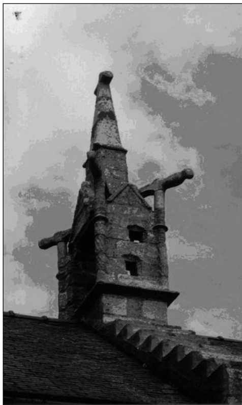
Fig. 3. – Ancien campanile, partiellement restauré, au droit de l'arc-diaphragme.
