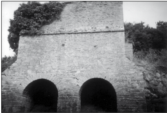
Fig. 5. – Latrines du sud-est, au-dessus de l'estran. Arcs en microgranite local bien façonné. Cliché L. Chauris.
