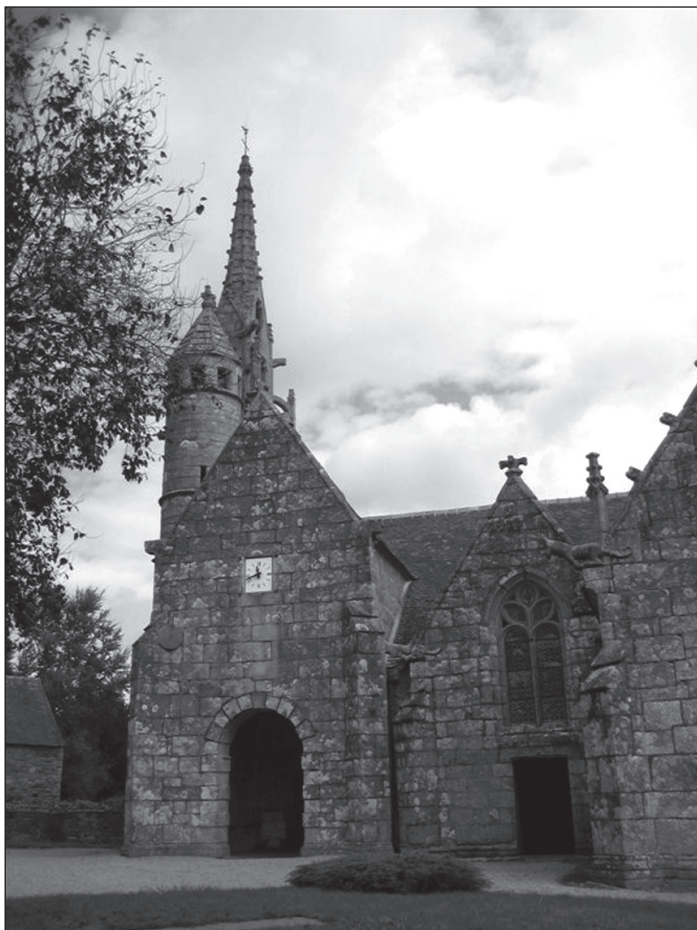
Fig. 31. – Trémel, église Notre-Dame , vue du côté sud. Cliché Jean-François Joly.
