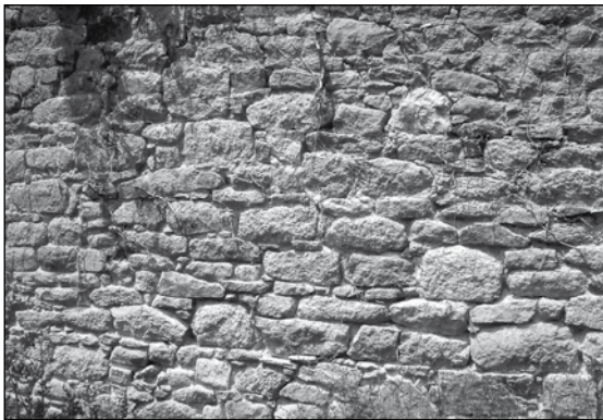
Fig. 4. – Mur en moellons hétérométriques de trondhjémite, offrant diverses nuances de teinte. Cliché L. Chauris.
