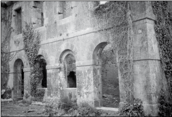
Fig. 8. – Bâtiment en L : ouvertures cintrées en granite type Ségala. Cliché L. Duigou.
