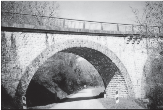
Fig. 6. – Sous l'arche la plus occidentale du viaduc, passage de la route D 236. Cliché L. Chauris.
