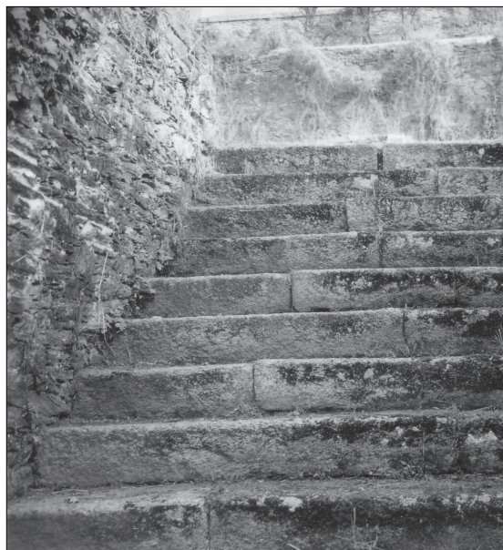
Fig. 32. – Partie médiane du troisième jardin. Marches vers le quatrième jardin, en grands éléments façonnés dans le granite de Callot.
