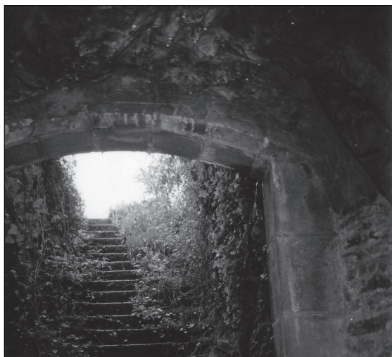
Fig. 42. – Débouché au jour de la batterie de rupture sous roc. Encadrement de la porte et marches en kersanton. Cliché L. Chauris.
