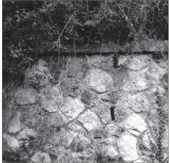
Fig. 13. – Parement de l'escarpe, riche en moellons quartzeux, vu des douves. Clichés Louis Chauris.
