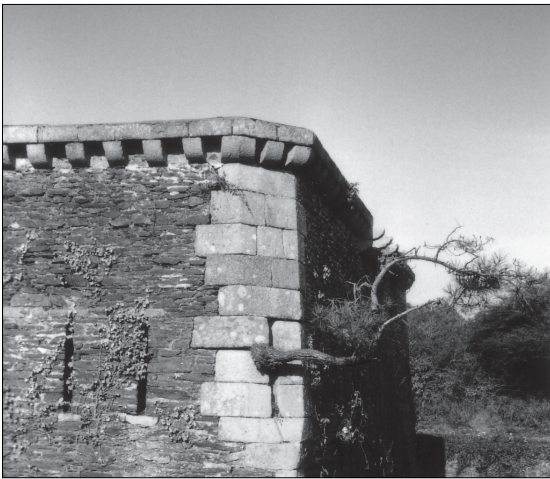
Fig. 37. – À l'un des angles de la tour carrée (1812) de la pointe des Espagnols. Association des pierres de taille du massif granitique de l'Aber-Ildut aux moellons schisteux d'extraction locale. Cliché L. Chauris.
