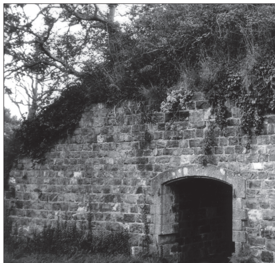
Fig. 18. – Casemate-abri de la batterie au nord de la redoute de Landaoudec. Encadrement de l'ouverture en pierres de taille façonnées dans le granite rose de l'Aber-Ildut. Moellons assisés en grès armoricain. Cliché Louis Chauris.
