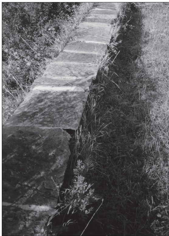
Fig. 33. – Couronnement de la murette du quatrième jardin.
