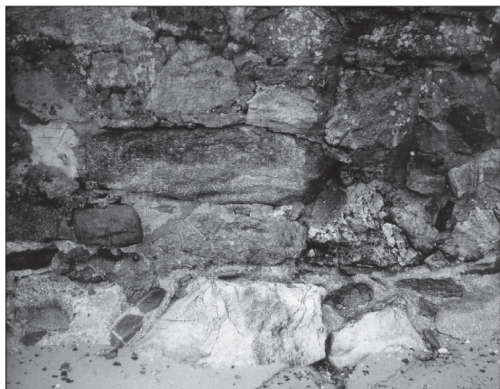
Fig. 8. – Mur édifié au sud de la vieille cale, en moellons hétérométriques à peine façonnés. Granite aplitique très clair, à tourmaline (en bas, au milieu), granite gris, quartz blanchâtre... Cliché Louis Chauris.
