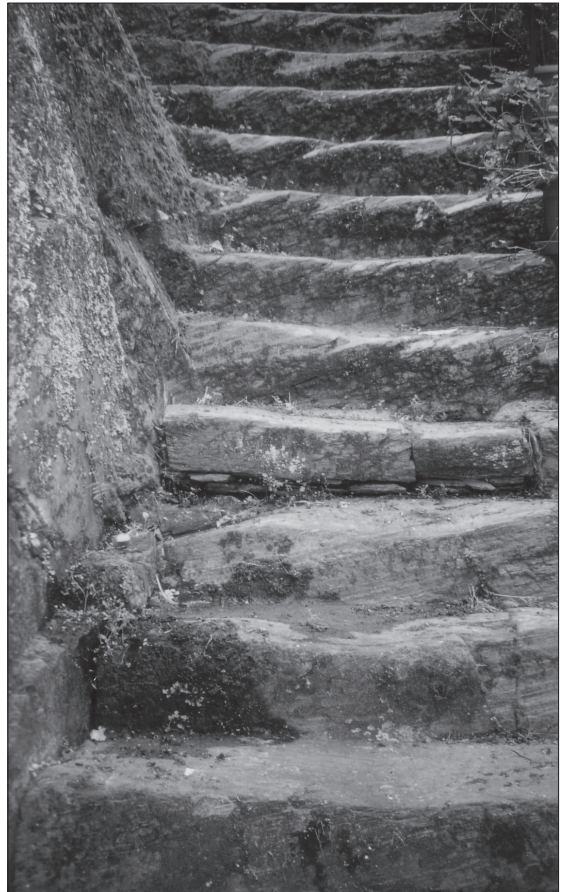
Fig. 25. – Escaliers extérieurs, taillés dans les schistes zébrés, menant de la cour au premier jardin.
