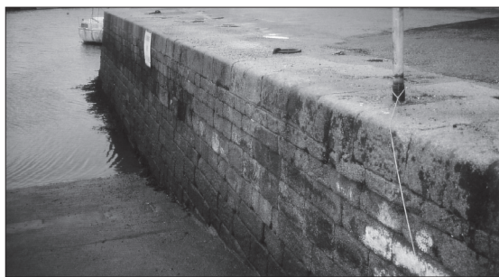
Fig. 3. – Au droit de la deuxième cale, mur du quai en beaux éléments granitiques régulièrement assisés.
