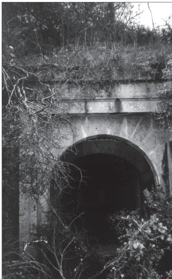
Fig. 17. – Porte monumentale, en plein cintre, à l'entrée de la redoute (avant les travaux de débroussaillage). Pierres de taille soigneusement façonnées dans le granite à gros feldspaths roses de l'Aber-Ildut. Cliché Louis Chauris.
