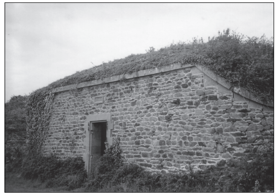
Fig. 40. – À l'ouest de la tour de 1812, batterie haute de la pointe des Espagnols (1883).
