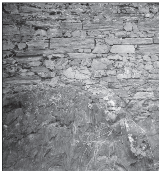
Fig. 26. – Schistes zébrés en place, surmontés par le mur de soutènement du deuxième jardin. Moellons schisteux hétérométriques. Cliché L. Chauris.
