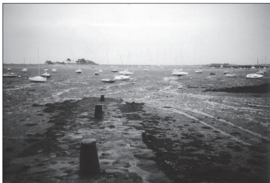
Fig. 6. – La vieille cale, en moellons hétérométriques, très polyolithiques.
