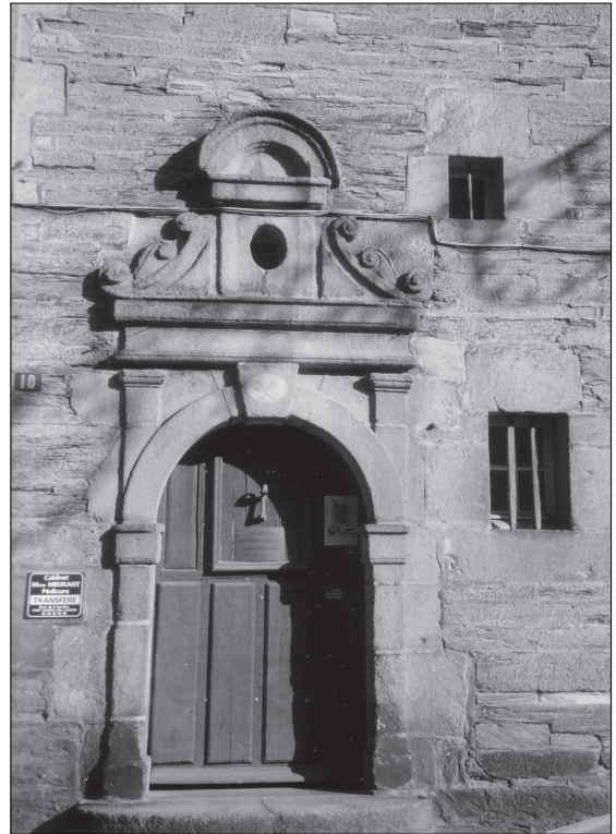
Fig. 28. – Porte médiane, côté rue. Granite rose de l'île Grande. Élévation en schistes zébrés bleutés. Cliché L. Chauris.
