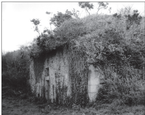
Fig. 41. – À l'est de la tour de 1812, batterie haute de la pointe des Espagnols. Chaînage d'angle et porte à imposte en granite porphyroïde rose de l'Aber-Ildut. Moellons en microgranite de Trébéron-île des Morts, et quartzites locaux... Cliché L. Chauris.
