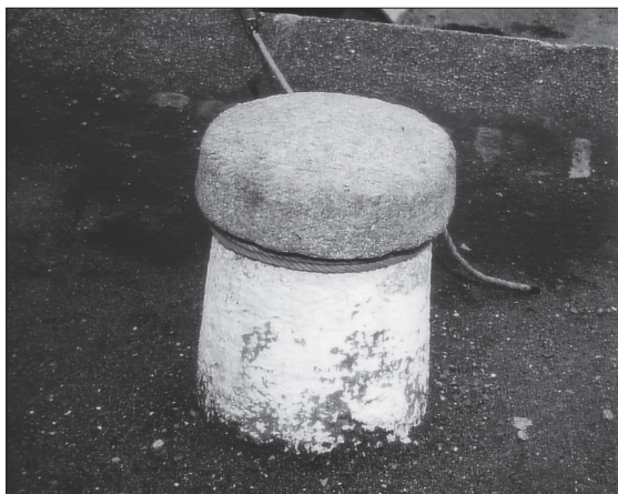
Fig. 4. – Bitte d'amarrage en granite de Cléder, entre le môle et la vieille cale. Tablette du quai, également en granite de Cléder.
