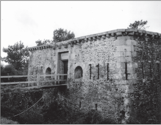
Fig. 36. – Vue d'ensemble, du côté de l'entrée, de la tour carrée (16 x 16 m sur une hauteur de 9 m) de la pointe des Espagnols (1812). Cliché L. Chauris.
