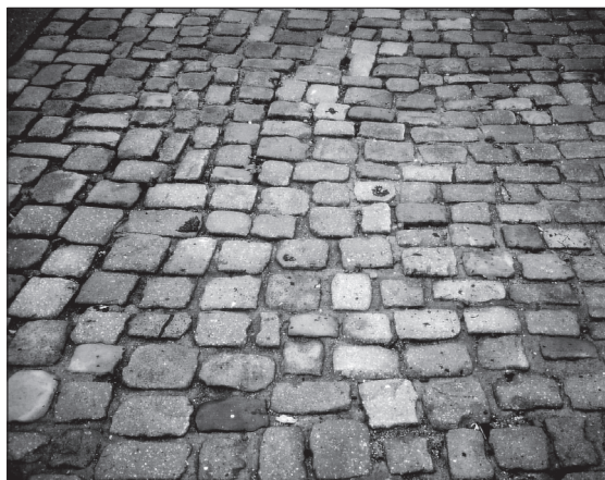
Fig. 5. – Le pavage du môle, en microgranite de l'île Longue et accessoirement de Rostellec (plus clair) a été refait. Le môle lui-même est aujourd'hui bétonné.
