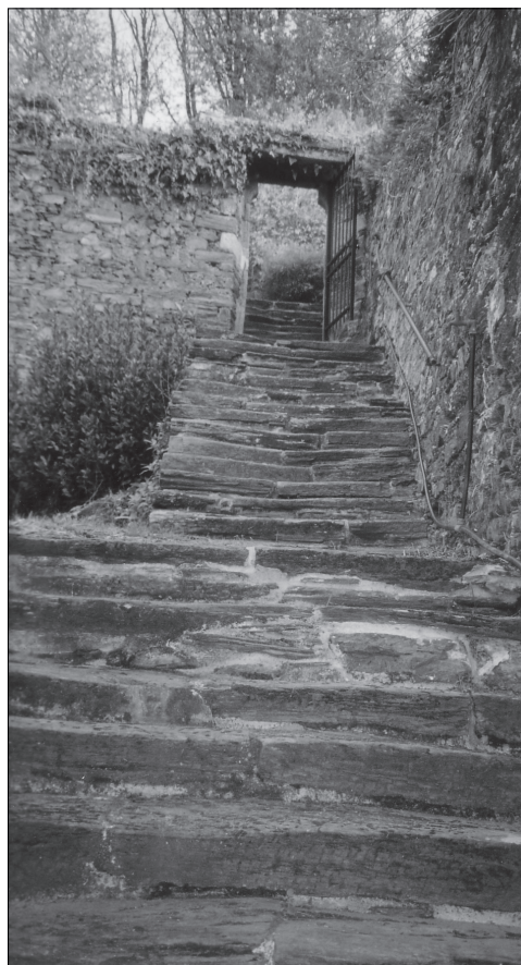
Fig. 27. – Marches en grands éléments schisteux vers le troisième jardin. Cliché L. Chauris.
