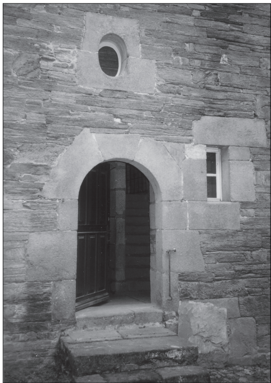
Fig. 29. – Porte d'accès à la cour, au niveau du premier étage. Granite rose de l'île Grande. Cliché L. Chauris.
