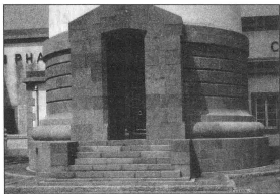
Fig. 6. – Porte d'entrée, un peu lourde, dans la tour du Creac'h.
