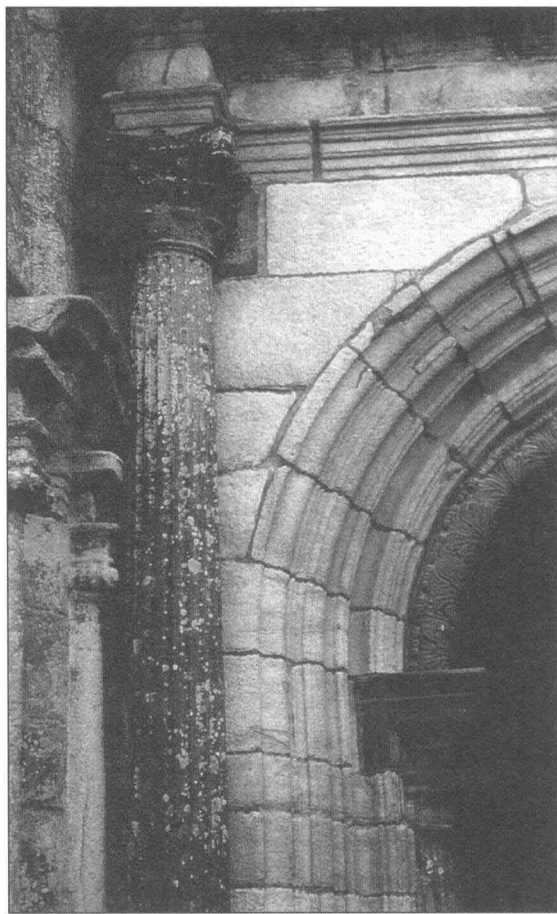
Fig. 22. – Partie gauche du porche méridional.
