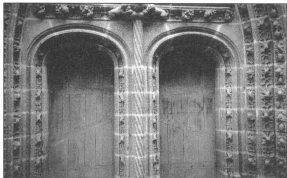
Fig. 24. – Plonévez-du-Faou, église Saint-Herbot, portail avec ouvertures géminées au pied de la tour.
