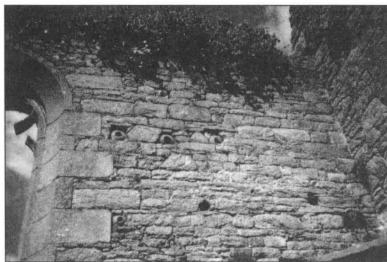
Fig. 8. – Vases acoustiques dans le mur septentrional, en moellons, de la chapelle.
