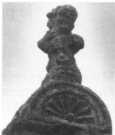
b. saint Pierre, face nord
