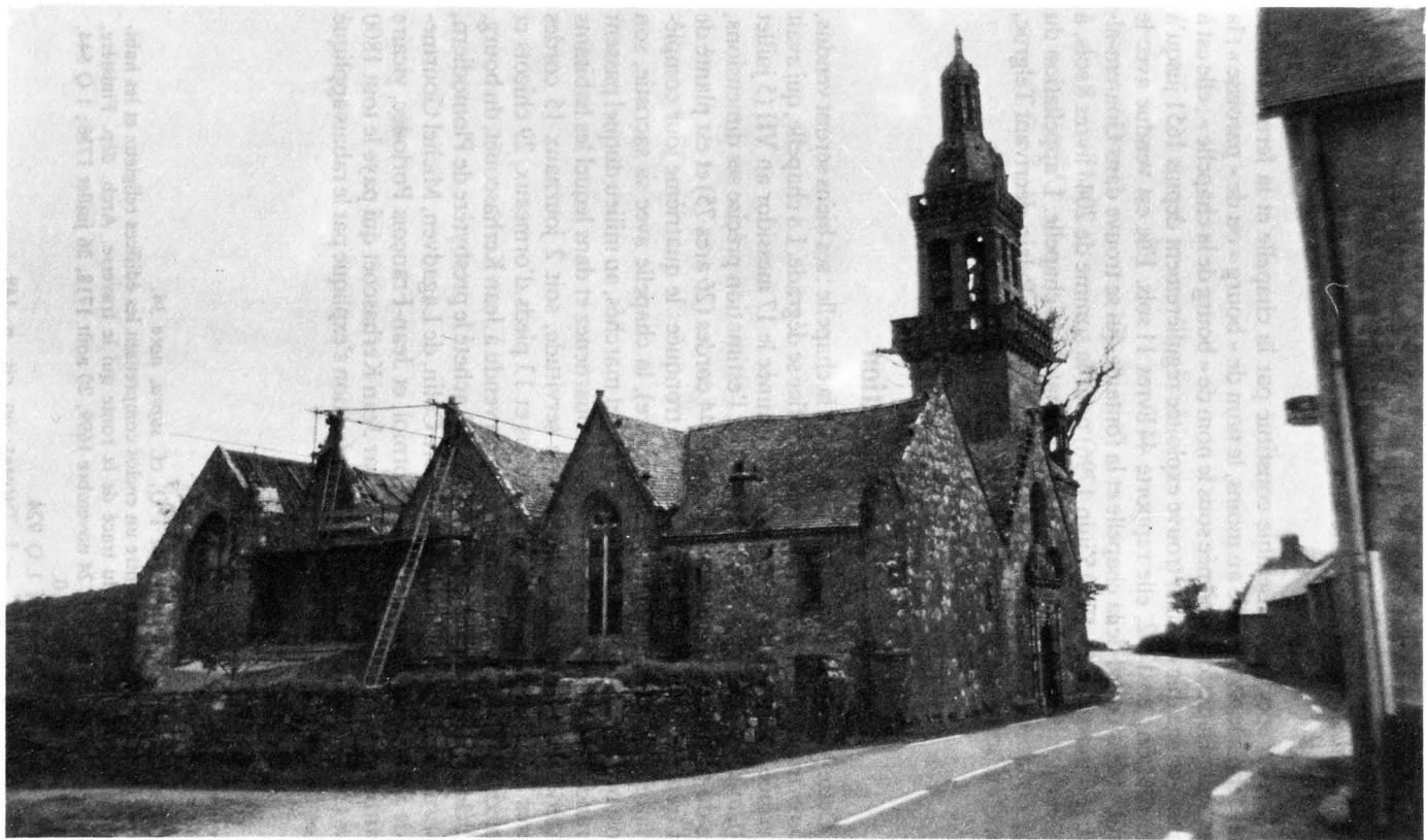
Fig. 4. — Plomodiern, chapelle Sainte-Marie-du-Ménez-Hom . Vue du côté nord. Travaux sur la toiture, novembre 1988.
