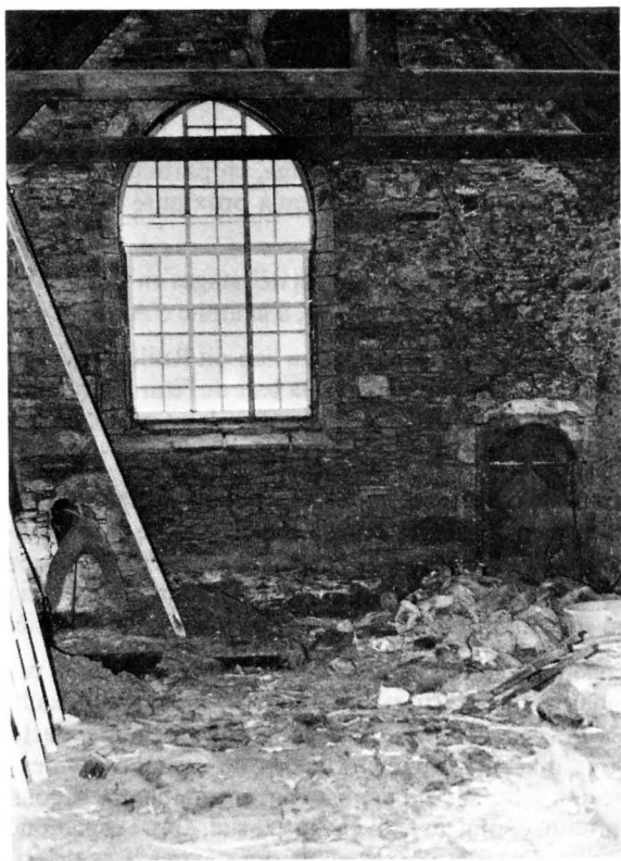
Fig. 1. — Concarneau, Ville Close , chapelle de la Trinité. Travaux en cours au mois de janvier 1985. Cliché L.-P. Le Maître.
