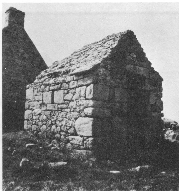
Fig. 11. — Ile de Sieck, magasin pour 200 kg de poudres. Sur le mur est visible l'ouïe de ventilation, avec double chicane intérieure.
