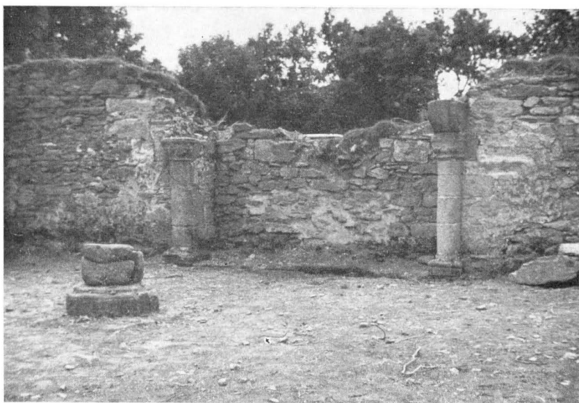
1. - Cheminée de la salle A
