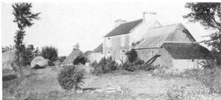
A : Ferme Charreteur à Kerlouzern (4 ha 1/2 dont 2 de labours). Bâtiments en ligne. Lokenn ouvrant en bout devant la maison. Le fumier est sur l'arrière.
