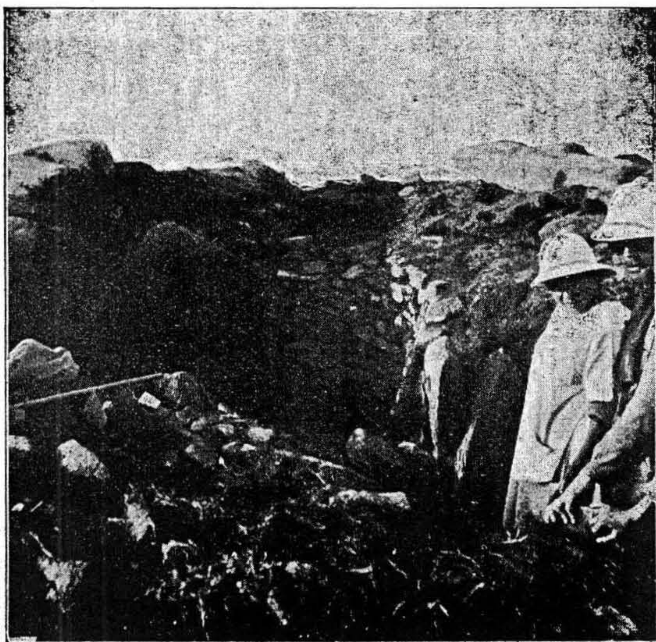
FIG. 8. — MUR EN PIERRES SÈCHES ÉLEVÉ À LA PLACE DES SUPPORTS DISPARUS
