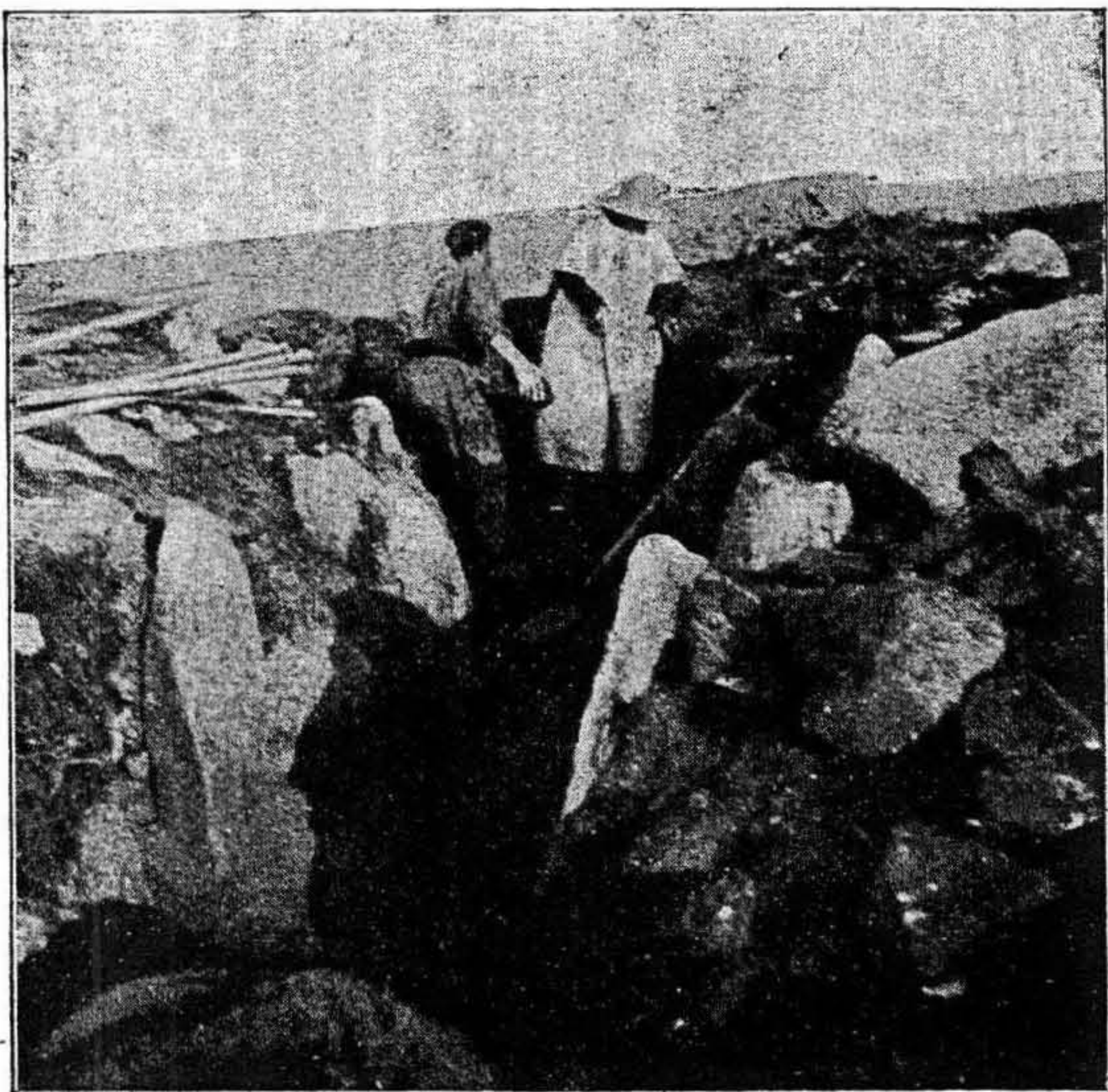
FIG. 7. — DÉGAGEMENT DE LA CHAMBRE
