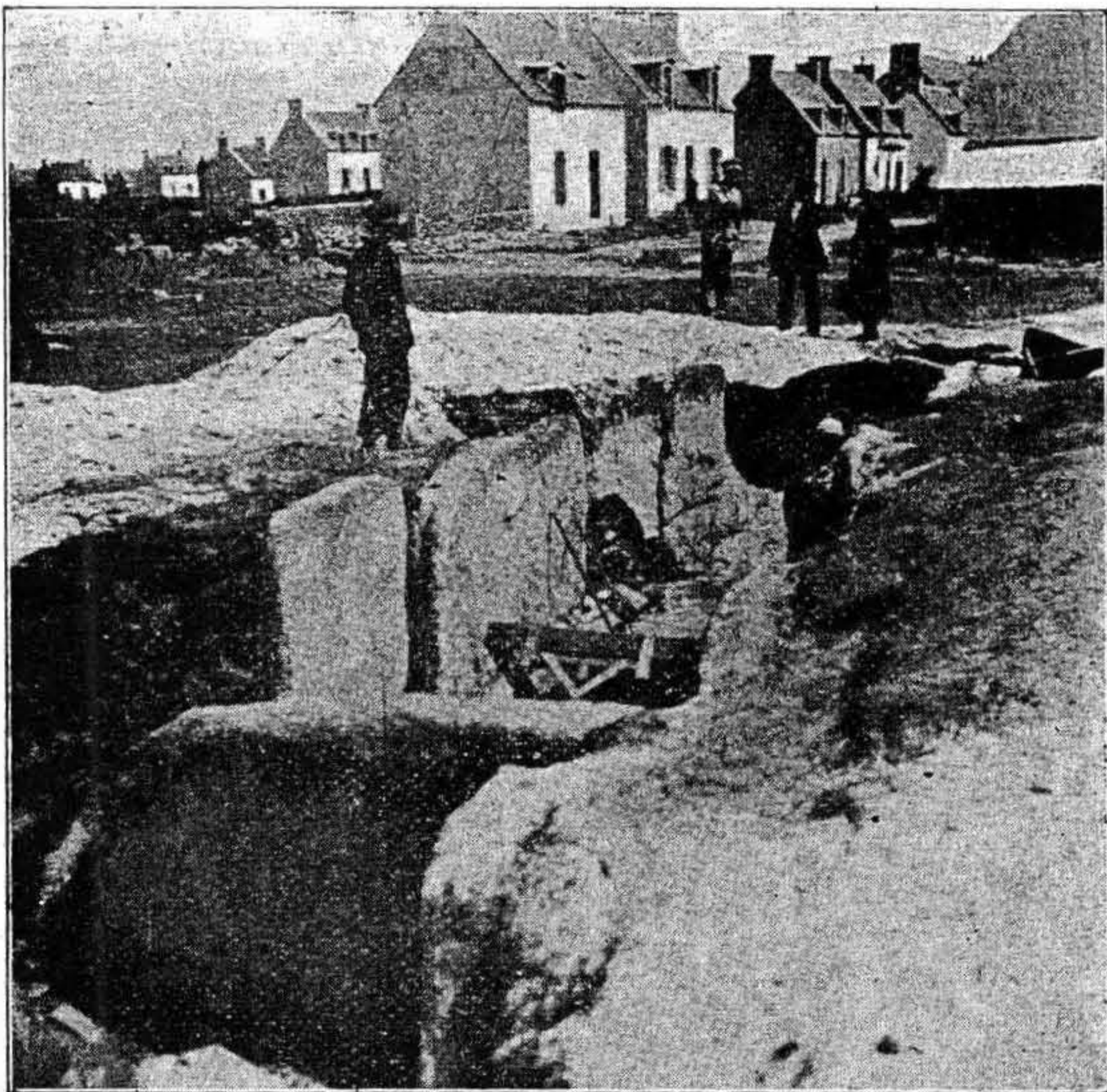
FIG. 13. — LES SUPPORTS REDRESSÉS
